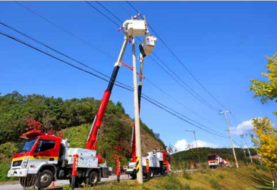
1, 4 한전 강원본부, 특고압 배전 간접활선 공법 시연 2 한전 동해안~신가평 특별대책본부 기자회견담회 3 동해안~신가평 송전선로 서부 구간 23차 입지선정위
