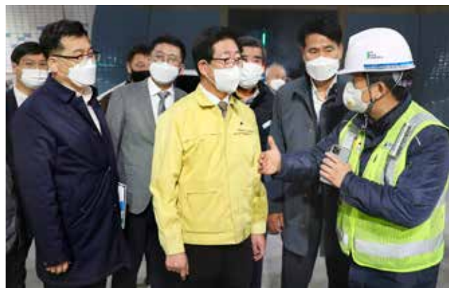
양승조 충남지사가 보령해저터널을 방문해 공사 진행 상황을 점검했다.
