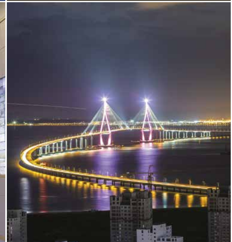
시민편의 중심 국제도시 기반시설 조성
