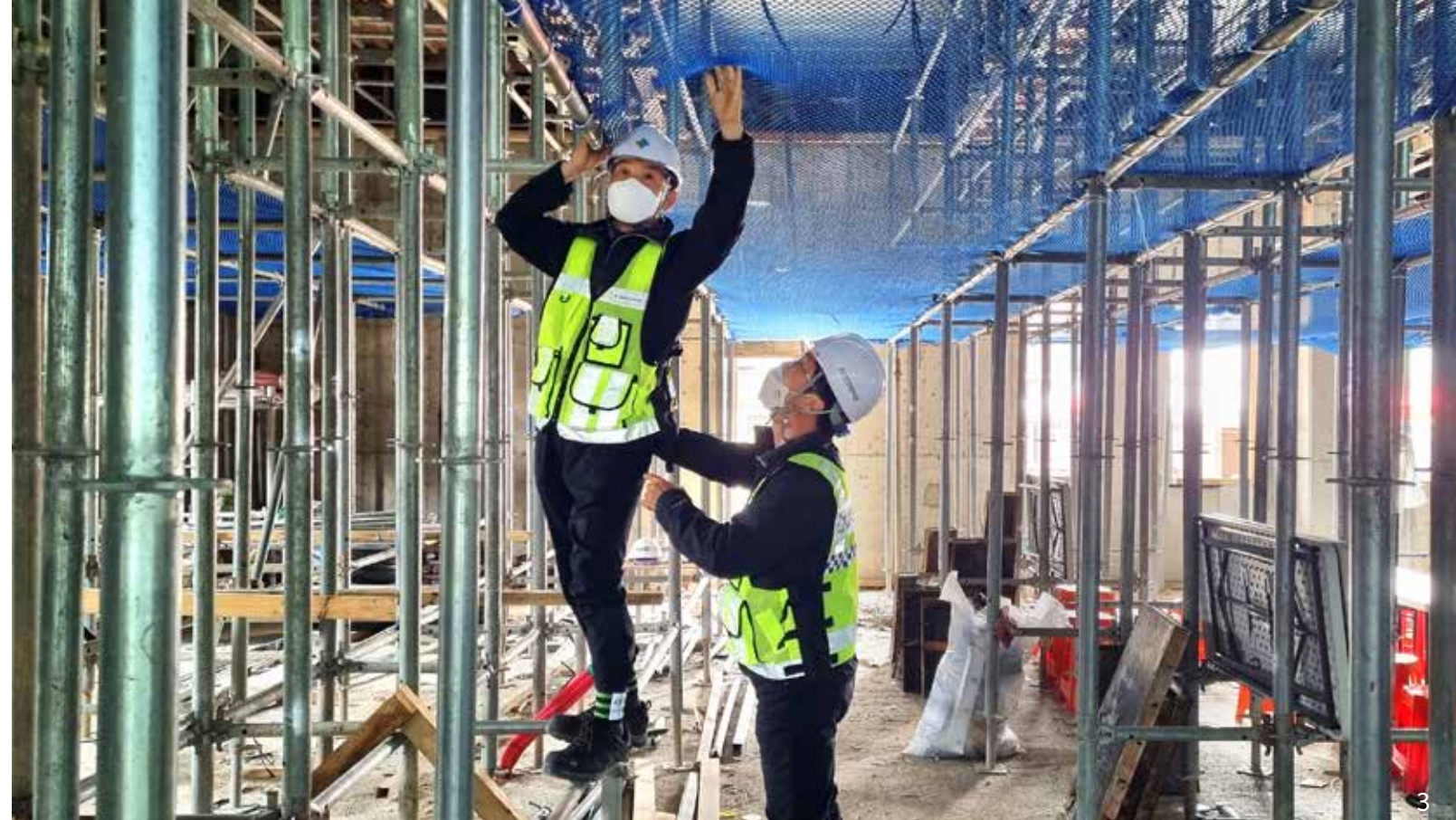
3 소규모 건설 현장 안전 점검 4 지능형 CCTV로 현장 안전 상태를 확인 중인 국토안전관리원 담당자
