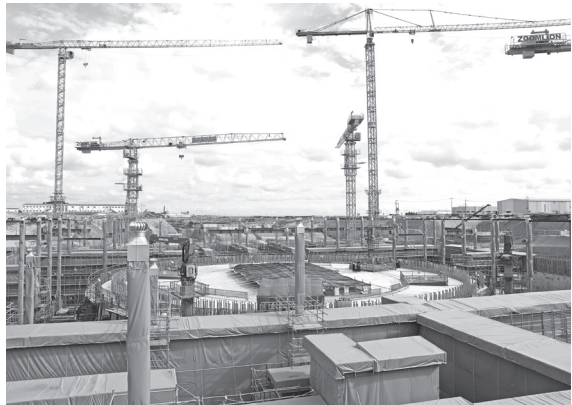
▲ 신고리 5·6호기 공론조사 결과 발표를 하루 앞둔 10월 19일 울산시 울주군 서생면 신고리 5·6호기 건설 현장의 모습. 공사 중단 기간 녹이 스는 것을 방지하기 위해 구조물에 방수포가 덮여 있다.
